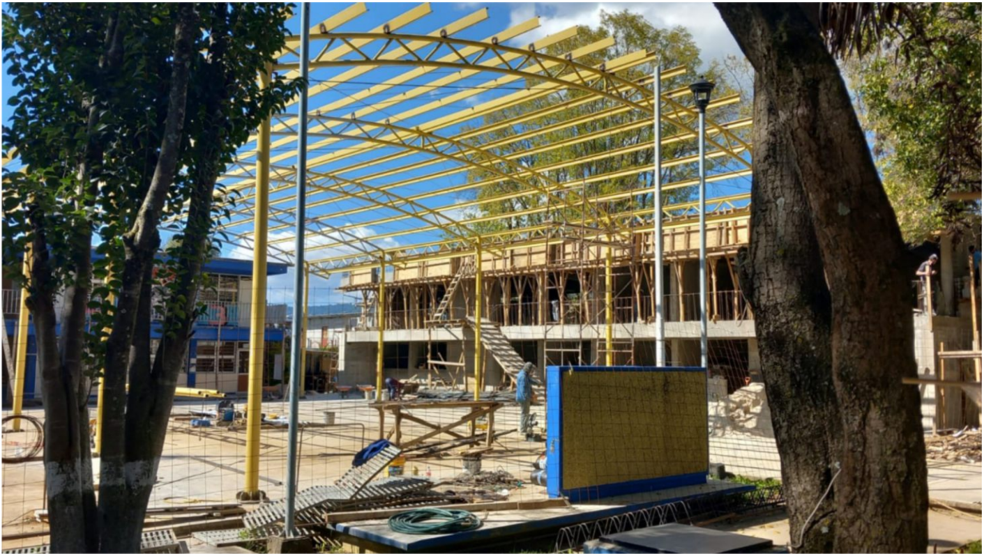
Avances de la construcción, noviembre 2024
